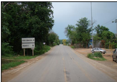
ถนนสายหลักทางหลวงแผ่นดินหมายเลข ๒๓๑๑
